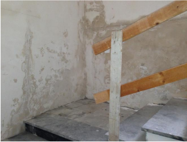
Pareti a terzo livello a contatto con il terrapieno di C.so Mazzini
