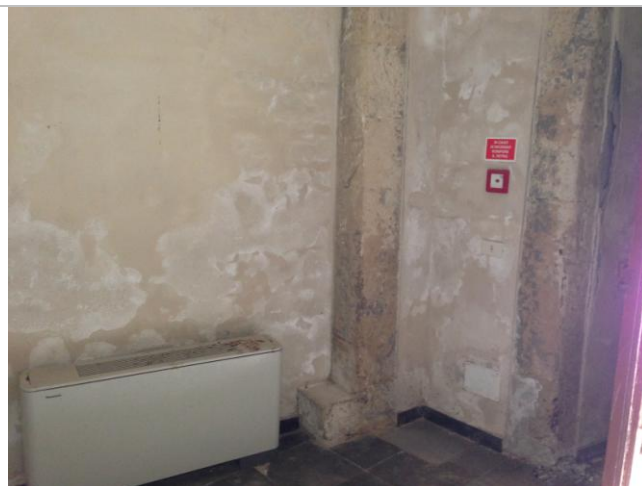
Vano d'ingresso a primo livello. Particolare umidità di risalita
