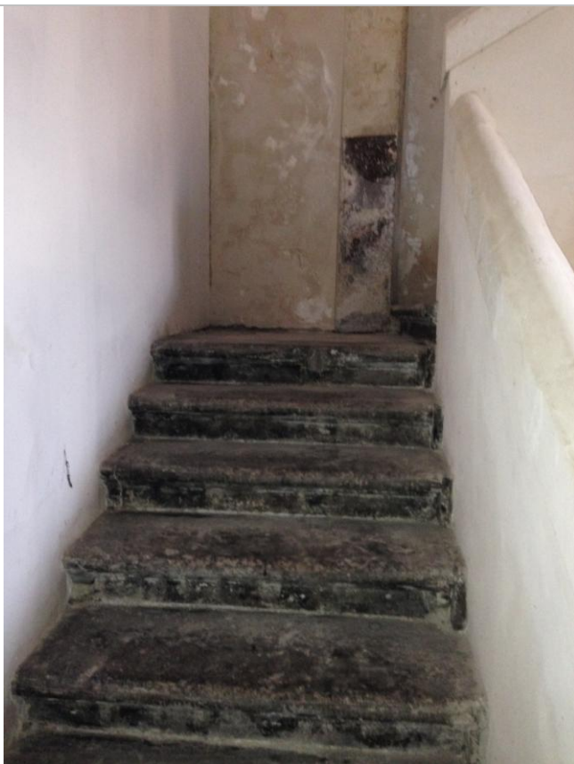
Scala alla "catalana". Rampa a primo livello
