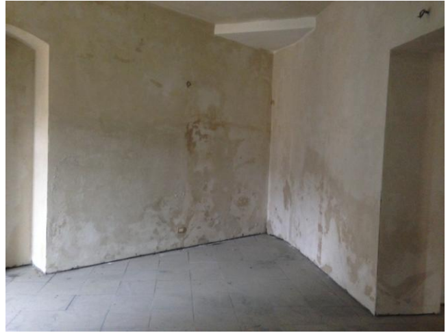
Pareti a terzo livello a contatto con il terrapieno di C.so Mazzini
